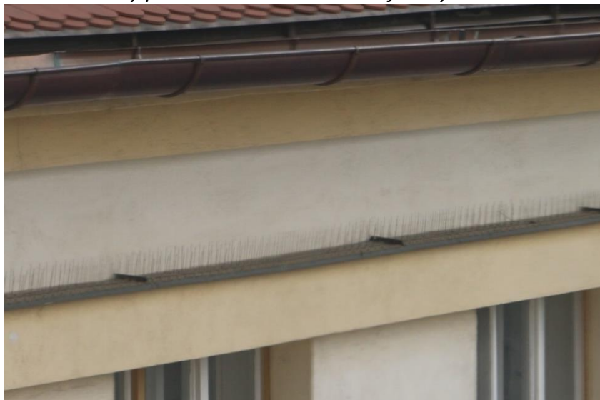
Obr. 14: Hroty proti holubům na římsách fasády
