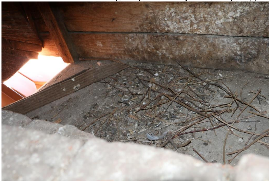
Obr. 23: Otvor v úžlabí střechy, kudy se dostávají holubi na půdu; patrné základy hnízda
