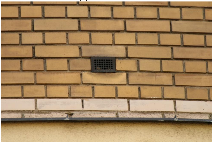
Obr. 15: Větrací otvor krytý mřížkou
